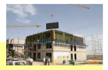
• Los encofrados pesan muy poco. El peso medio para encofrado de muro es de 68 Kg. por M² y en los techos de 40 Kg. por M². Por ejemplo el peso total de los encofrados para un edificio de dos viviendas de 84 M² es como medio 298 Kg.
