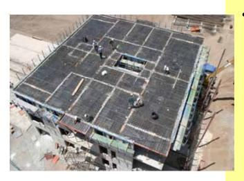
Para ejecutar la cubrición de techo, sobre el hormigón de formación de pendiente se colocarán dos capas de impermeabilizantes, sobre los que se colocarán piezas de poli estireno con dimensiones 200\*100\*5 cm. Se colocará el acabado final de techo con un mortero de cemento sobre cubrición de poli estireno de 5 cm. De esta forma tendremos aislamiento acústico en todos los suelos e impermeabilizante de humedad en techo.
