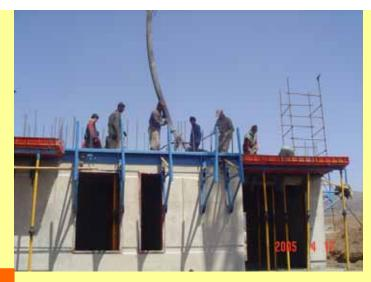
Se realizará el hormigonado de techo de una vez y uniforme con la bomba.  Cuando se bajan los gatos de los raíles, se separarán los encofrados del techo y se recogerán y se sacarán del lugar con facilidad. Después de desencofrar el techo se seguirá con el armado y encofrado de muro para el siguiente piso.
