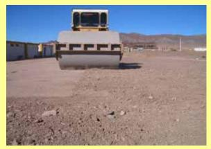
• Sobre la tierra compactada se prepara la superficie de apoyo de la fundación mediante una capa de hormigón pobre de 10 cm. según plano.
