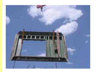
• Los encofrados a pesar de ser grandes se instalan con rapidez y se colocan con precisión, poseen mayor durabilidad y ofrecen mayor calidad. Sobre todo permiten repetir todo el conjunto después de 24 horas, lo cual no es posible en ningún sistema de encofrados metálicos ni de maderas.
