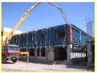
Una vez fijados los encofrados se hormigonado. realiza el Dicho hormigonado se ejecuta de una vez mediante la bomba y al día siguiente quitan los encofrados inmediatamente se limpiarán y se engrasarán y en unos minutos se instalarán en nuevo predeterminado según un programa de orden. En realidad en este sistema en vez de encofrar y desencofrar, lo que se hace es instalar y trasladar.
