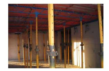
Cada encofrado podrá tener hasta 200 usos. Si las conservaciones y reparaciones se hacen correctamente y después de una reparación a fondo, se podrá repetir este ciclo.
