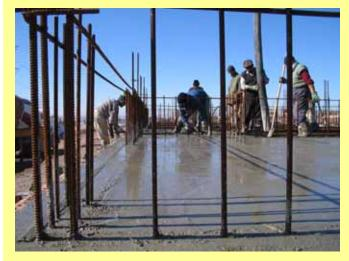
Después de ejecutar el hormigón de la fundación, se colocará la parrilla del muro atándole a las armaduras de espera, que salen de la fundación. De esta forma quedan totalmente atados la fundación y el muro mediante las armaduras.
