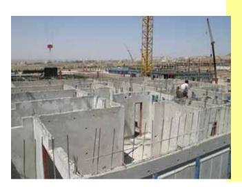
Es considerable la flexibilidad de este sistema, aunque en el principio parezca lo contrario. Para tener libertad de diseño en arquitectura interior y así mismo para permitir posibles cambios posteriores, podemos no considerar elementos estructurales de hormigón, hasta el 50% de los muros interiores y utilizar otros materiales de partición.
