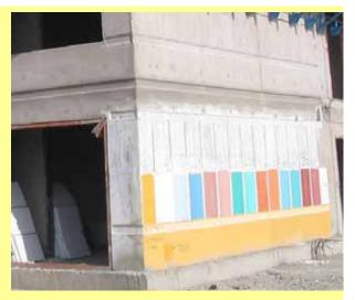
Comparando el edificio con otro tradicional, en este momento dicho edificio se encuentra preparado para los trabajos de acabado final. Después de limpiar la obra se podrá empezar a pintar o empapelar los muros sin necesidad de hacer acabado con yeso o cualquier otro material.
