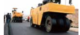
Reconstruction et élargissement de l'autoroute départementale de l'Andhra Pradesh
