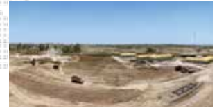
Usine d'épuration d'eau et les canalisations de transfert de la ville Al Nassiriya
