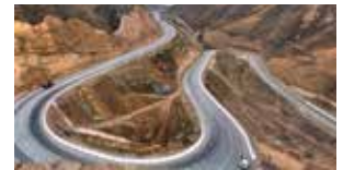
Reconstruction et élargissement de la route Bishkek-Osh
