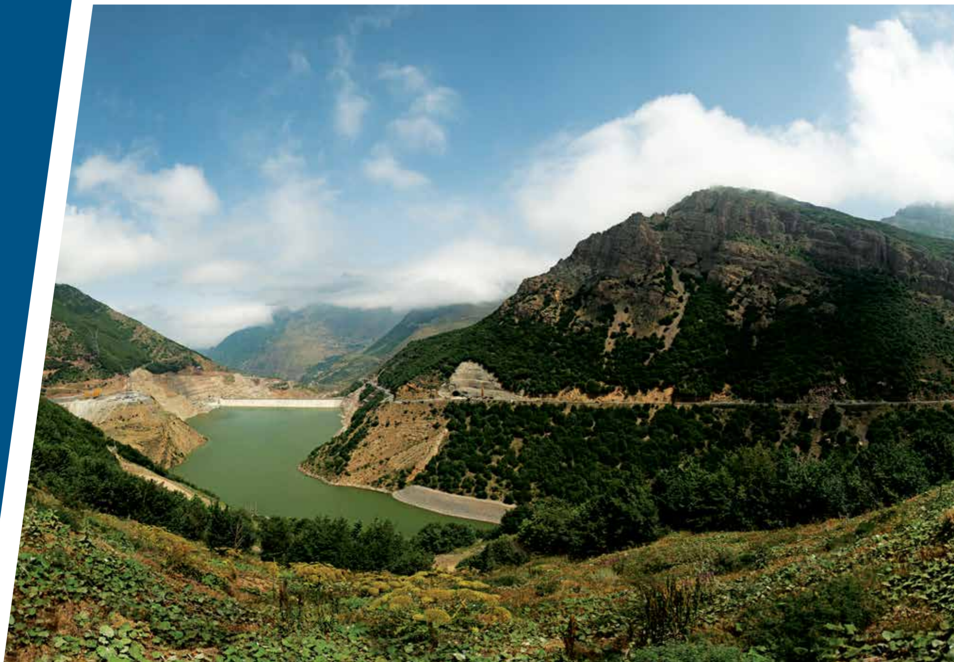
سدهای بالا و پایین و سازه‌های وابسته طرح سد و نیروگاه تلمبه - ذخیره‌ای سیاه‌پیشه
