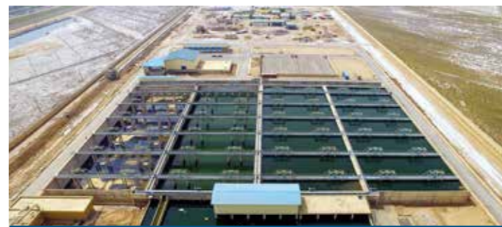
تصفیه‌خانه فاضلاب شرق اهواز
