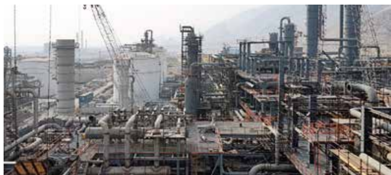
ابنیه صنعتی و نصب تجهیزات پتروشیمی دنا - عسلویه
