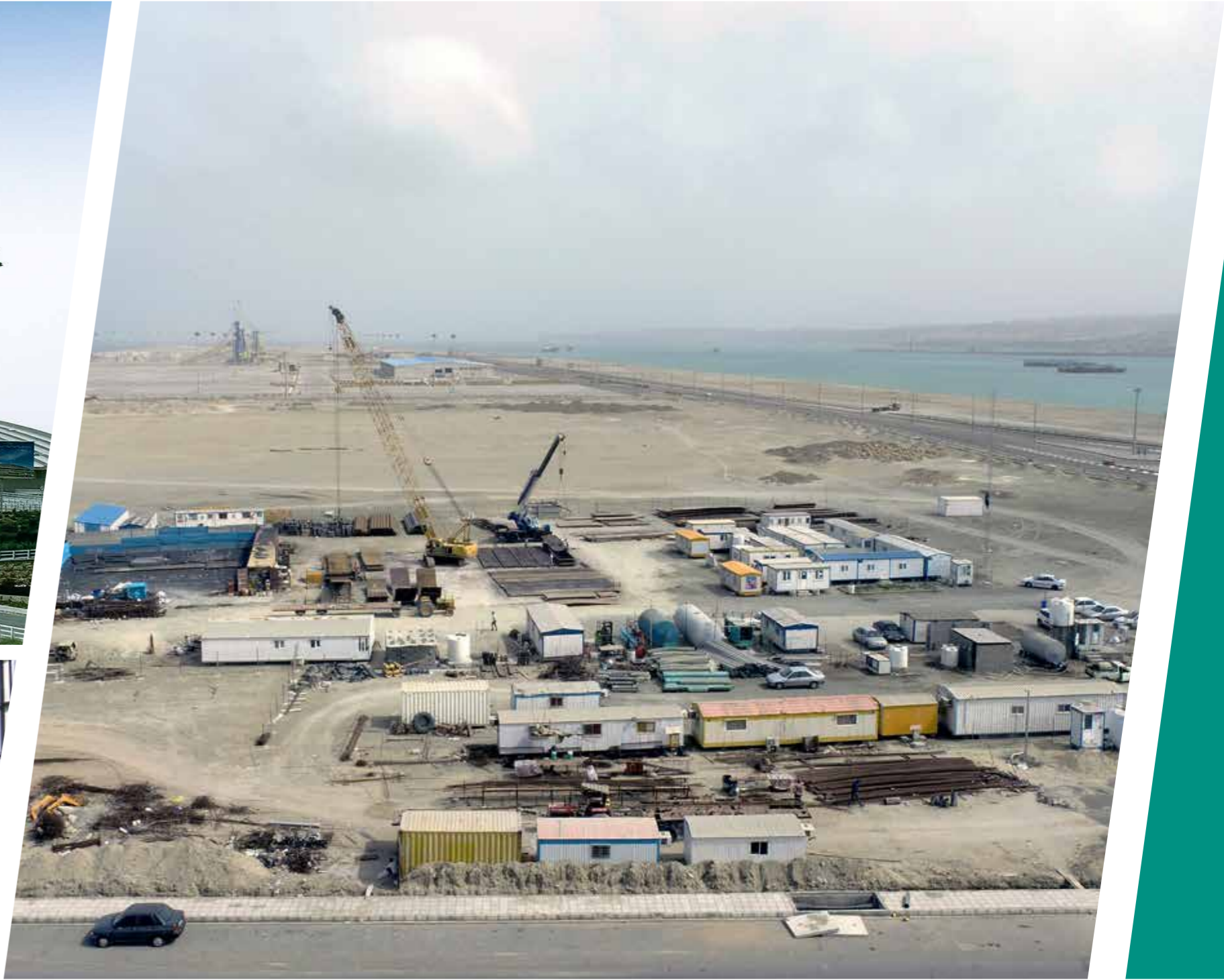
مجتمع ذخیره‌سازی قیر چابهار
